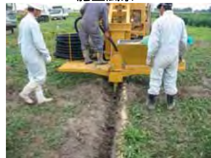
ベストドレーン工法によるパイプと初殻の同時埋設
