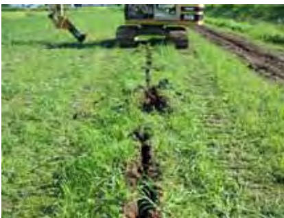
アーム式暗渠掘削機による前処理
