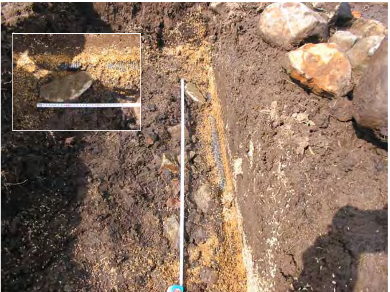
掘削後の石の状況(石はアーム式前処理により掘削ラインより左右に移動している)
