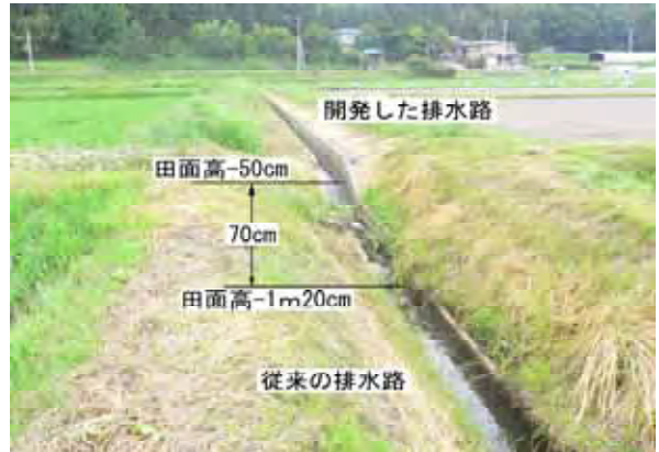
写真1 新工法による排水路
