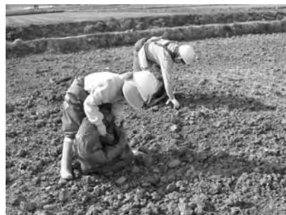
写真3 施工後の石拾い
