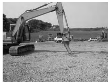
写真6 ガイド掘削機
