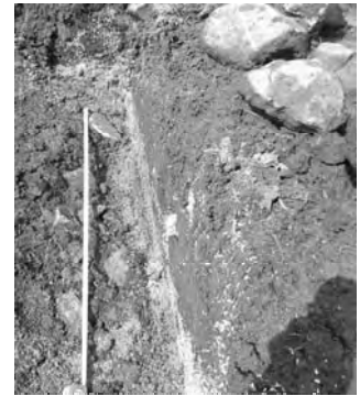
写真8 石の多い場所の 施工状況
