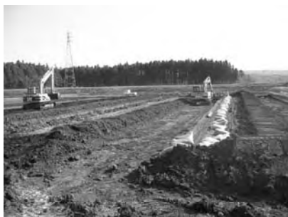
写真1 石が多い場合の暗渠工
