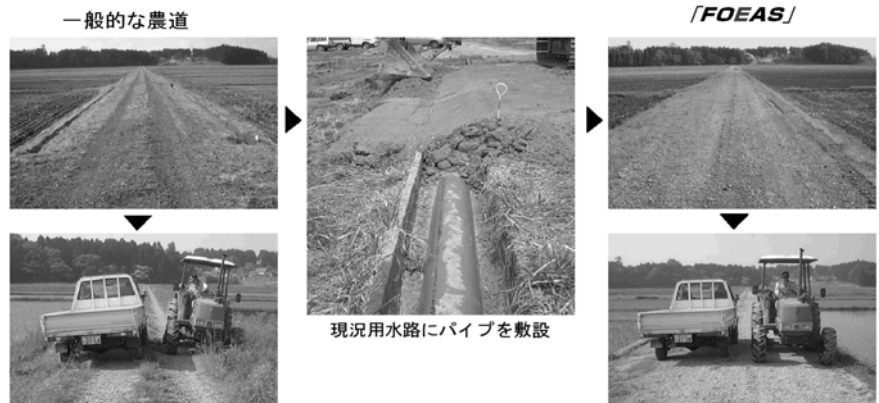
写真2 開水路のパイプライン化による農道の拡幅
