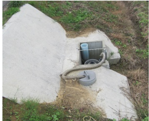
コンクリートによる給水柵（フォース柵）および水位管理器の保護事例
