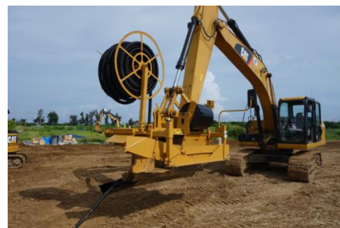
図 2 従来工法 (非開削型) の概要
