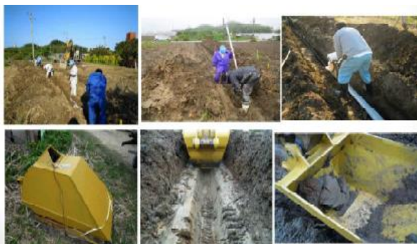
図 1 従来工法 (開削型) の概要
